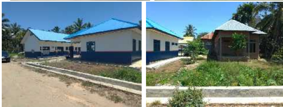
Gambar 5.3. Tanah SDN 2 Keisio yang Sedang Digugat
